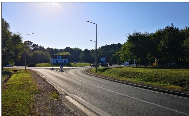
GIRATOIRE « CABANE OSTREICOLE » DE LA RD 14 ET ENTRÉE PRINCIPALE DE CHAILLEVETTE SUR LA RD 140- A DROITE AIRE DE COVOITURAGE
