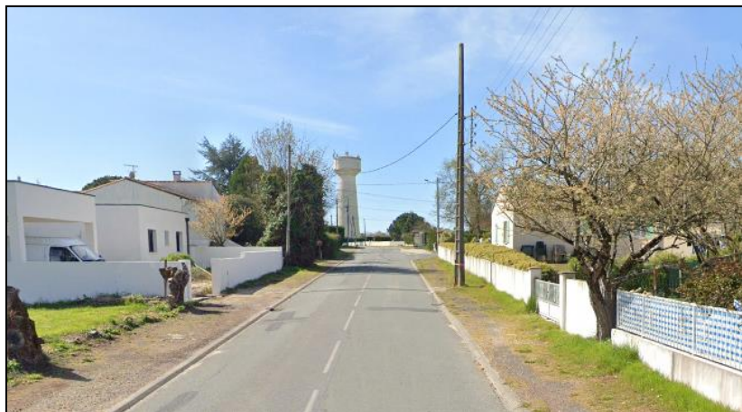
QUARTIER AUTOUR DU CHÂTEAU D'EAU
